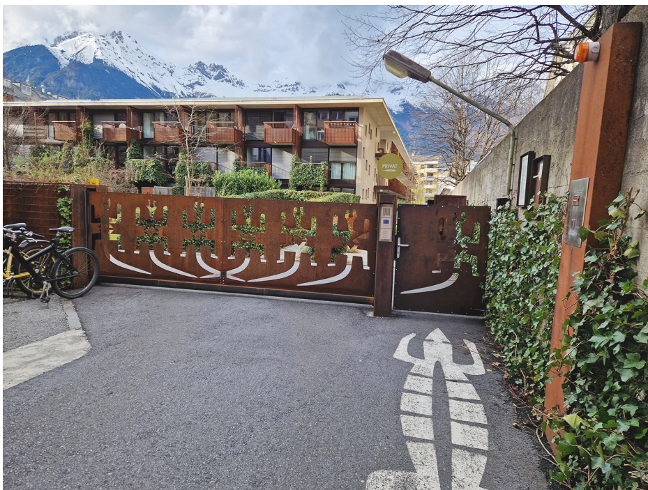
Abb. 2: Privates Apartmenthaus mit 118 möblierten Wohneinheiten (Ein- bis Zweizimmerwohnungen) im Stadtteil Wilten, Innsbruck
